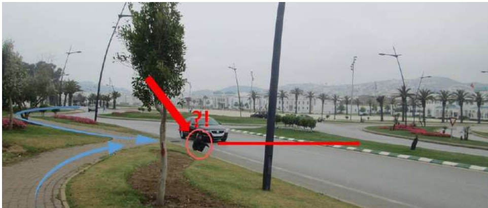
Figure 67. Aménagements paysagers avec cheminement piétons (en bleu) mais sans continuité avec les passages piétons qui sont absents et laissent les piétons là où ils en ont plus le besoin, ici à M'diq. Source : photo CID.
