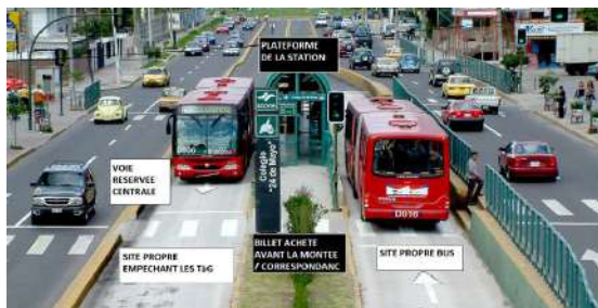
Figure 82. Exemple de BRT, à Quito, avec les caractéristiques typiques. Source : www.itdp.org, What is BRT?
