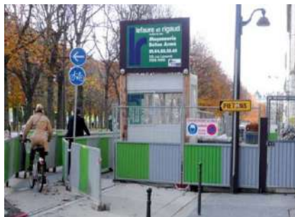
Figure 183. Piste provisoire à côté d'un trottoir provisoire. Source : Certu 2010.
