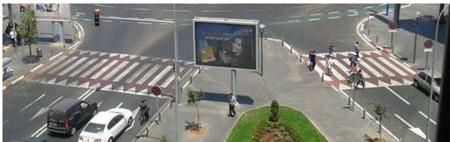
Figure 66. Exemple de plateaux ralentisseurs en blanc sur fond rouge en Place Europe à Casablanca. Source : internet.
