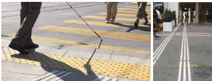
Figure 121. Dispositifs pour personnes avec déficience visuelle : bande d'éveil de vigilance à gauche et bande de guidage à droite. Source : Directive sur l'abaissement des bordures de la Ville de Genève, 2007 et Les besoins des personnes déficientes visuelles de la CFPSAA, 2010.
