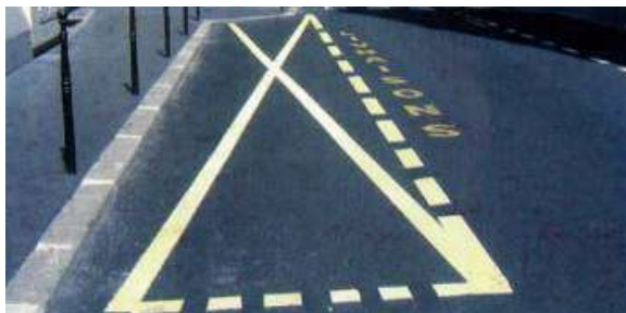
Figure 168. Signalisation d'une zone de livraison. Source : Guide de signalisation routière en milieu urbain, DRCR 2008
