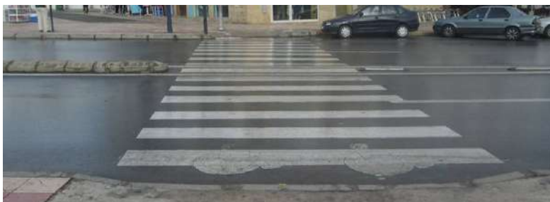
Figure 71. Exemple d'une traversée accessible aux PMR, à M'diq. Par contre, la zone refuge est trop petite pour héberger des personnes en fauteuil roulant ou avec des poussettes. Source : photo CID.
