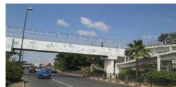
Figure 69. Passerelle pour la traversée des piétons. Source : Photo CID, Rabat
