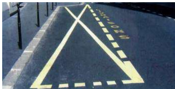
Figure 191. Signalisation d'une zone de livraison. Source : Guide de signalisation routière en milieu urbain, DRCR 2008
