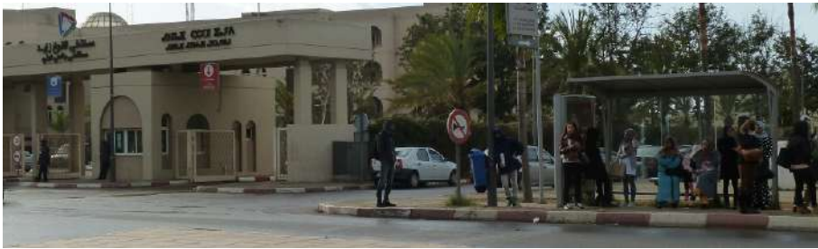
Figure 160. Entrée de l'Hôpital Cheikh Zayd, Rabat. Séparation des flux (véhicules, piétons, urgences) et bonne accessibilité piétonne et en transport collectif. Source : photo CID.
