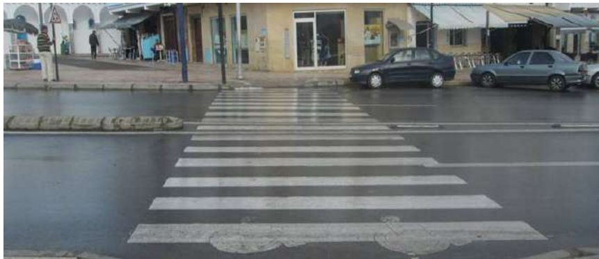
Figure 127. Exemple de traversée accessible grâce aux trottoirs abaissés, à M'diq. Par contre, la zone refuge est trop petite pour héberger des personnes en fauteuil roulant ou avec des poussettes. Source : photo CID.
