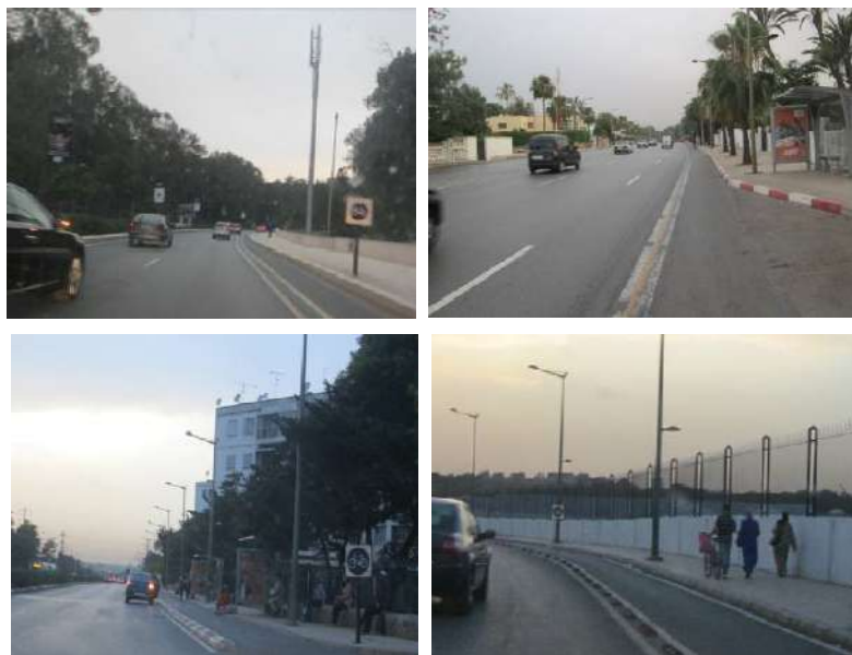
Figure 134. Bande cyclable unidirectionnelle avec marquage au sol ou avec délinéateur. Source : Photos CID.
