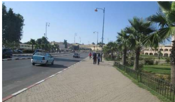
Figure 119. Trottoir large et doté d'un revêtement confortable. Source : Photo CID, Meknès.
