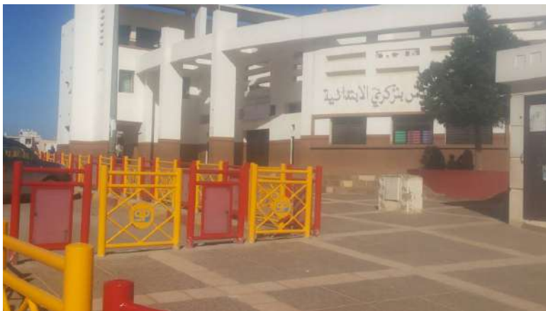
Figure 146. Exemple de garde-corps autour d'un établissement scolaire. Source : CNPAC, 2015.
