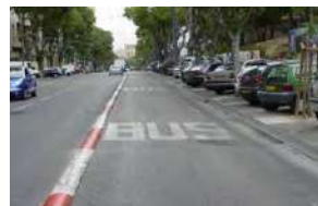
Figure 30. Exemple de séparateur physique franchissable à vitesse réduite. Source : Certu 2009.
