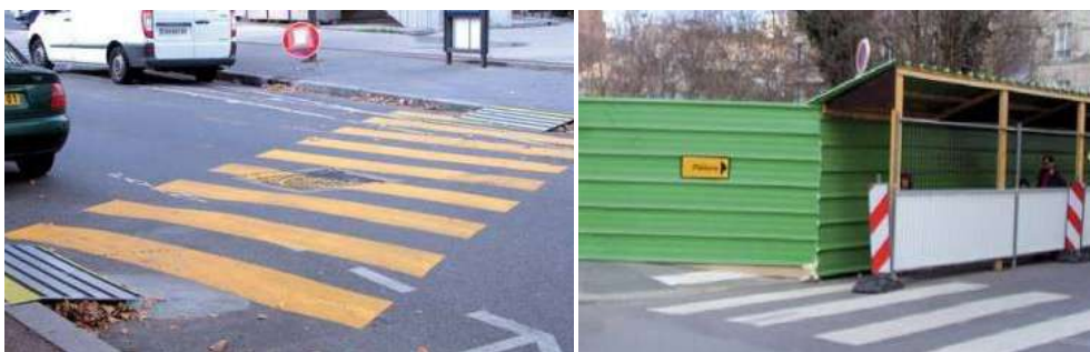
Figure 182. Exemple de passage piétons provisoire (en haut) et de trottoir provisoire (en bas). Source : Certu, fiche Les chantiers urbains, 2010.
