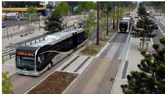
Figure 81. Exemple de BHNS avec véhicule et site propre dédié. Source : Certu
