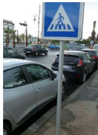
Figure 188. Incohérence entre la signalisation verticale et la signalisation horizontale : absence de marquage au sol pour le passage piéton, ce qui rend inutile l'implantation du panneau et favorise l'occupation du passage par les voitures en stationnement. Source : photo CID, Rabat.
