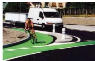
Figure 72. Élément séparateur pour cyclistes en entrée/sortie d’un carrefour giratoire ayant des trafics importants. Source : internet.
