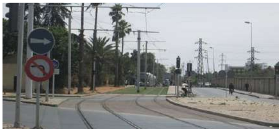
Figure 88. Intersection avec la plateforme d'un tramway: panneaux annonçant le régime de priorité favorable au tramway avec signalisation lumineuse, interdiction de certains mouvements tournants (ici depuis la sortie de la station d'essence sur la droite), différenciation de la section de la plateforme en intersection avec la chaussée (en premier plan dans la photo en haut et en blanc dans la prise satellitaire cicontre). Ci-contre : champs visuel de la photo dans le triangle bleu et site propre du tramway en orange. Source : CID, élaboration à partir d'image Google, Rabat.
