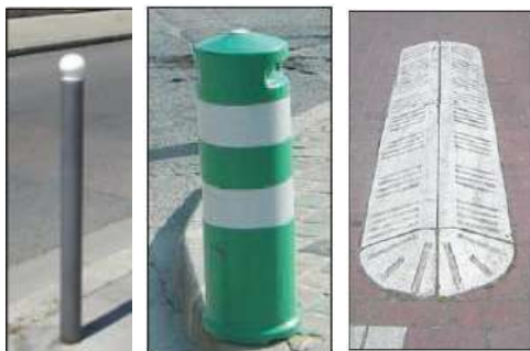
Figure 143. Exemple de potelets (d'environ 1,30 m en France, en métal, et de 1 m en Belgique, avec contraste chromatique) et de délimiteur de trafic. Source : Guide de conception des aménagements cyclables, Grand Lyon, Dir. voirie et fiche technique des pistes cyclables les manuels du MET 2006 Wallonie.
