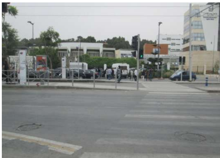
Figure 152: Cheminement piétons canalisé et sécurisé avec îlots et feux en correspondance de la station du tramway. Faculté des sciences, Rabat. Source : Photo CID.
